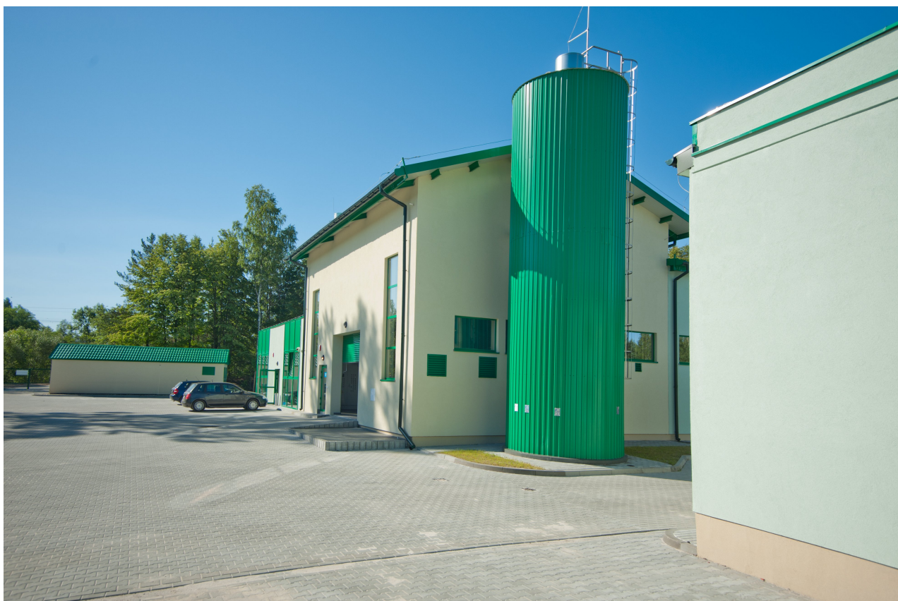
Fotografia 1. Budynek SUW Piaskownia przy ul. Bukowskiej 5 w Jaworznie.
