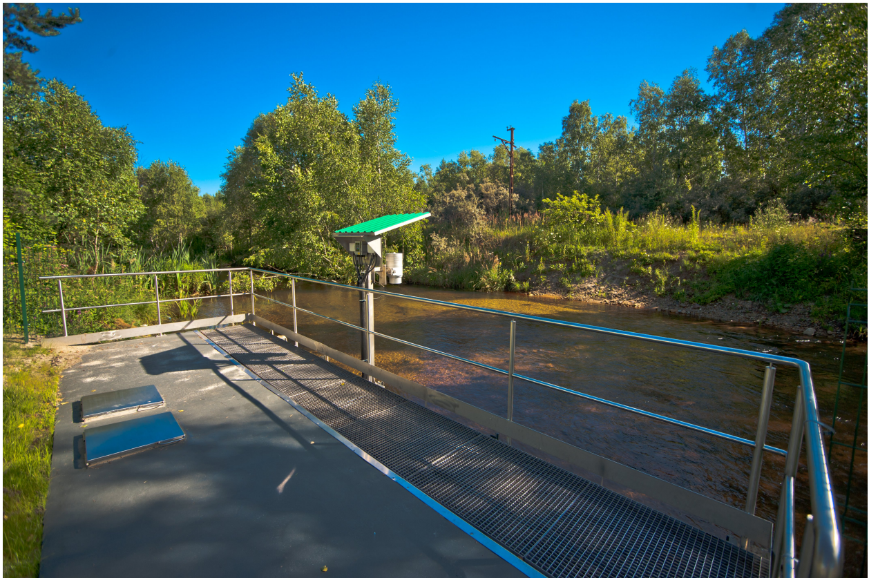
Fotografia 2. Miejsce ujmowania wody powierzchniowej dla celów wodociągowych - Kanał Centralny SUW Piaskownia, ul. Bukowska 5 w Jaworznie.
